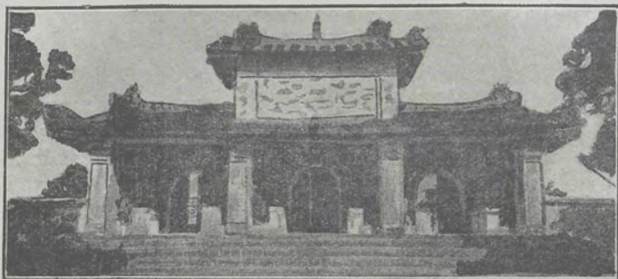
Portique, à la Tour de Confucius de Hué (A.V.H.).
