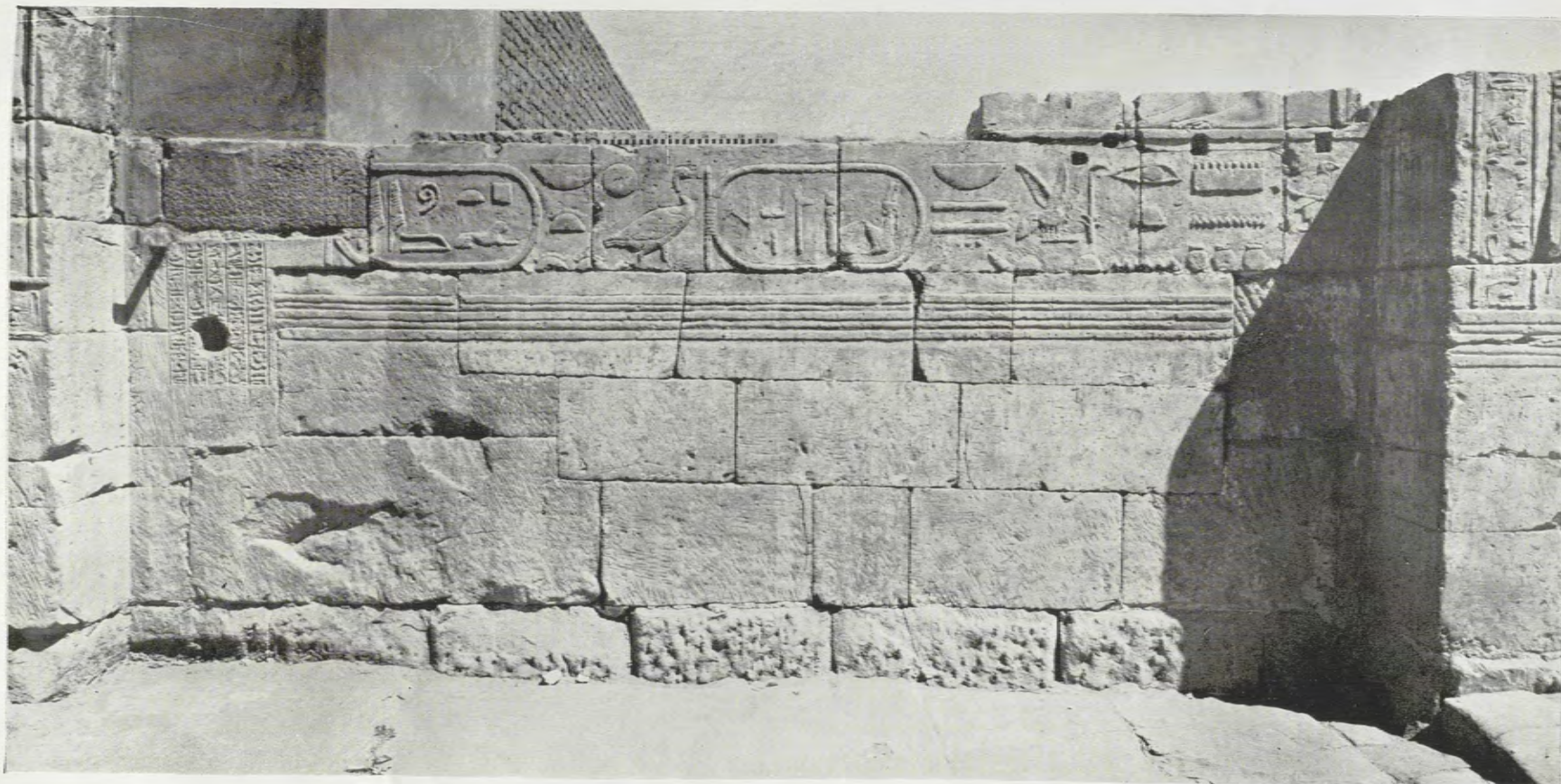
Paroi Nord de l'ébrasement du vantail.
