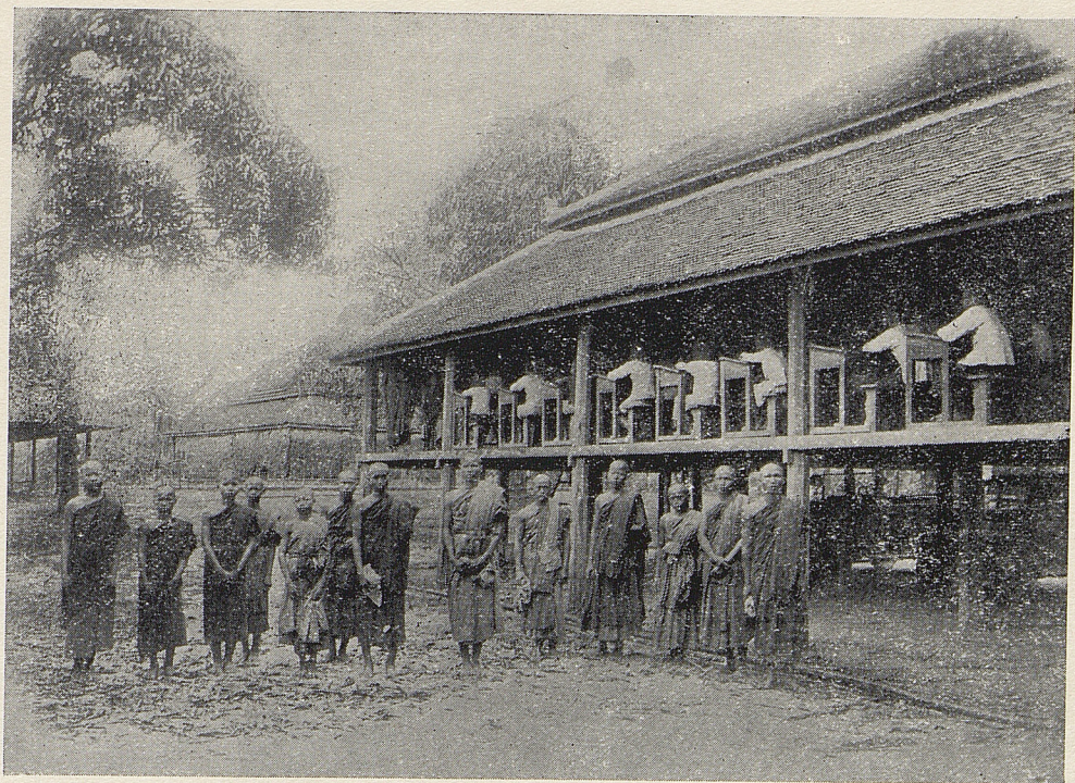
Une école de pagode rénovée (Kompul-Méas. — Cambodge)
