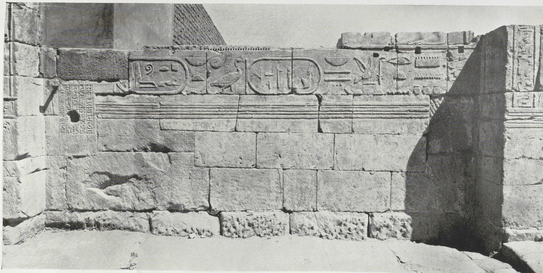
Paroi Nord de l'ébrasement du vantail.
