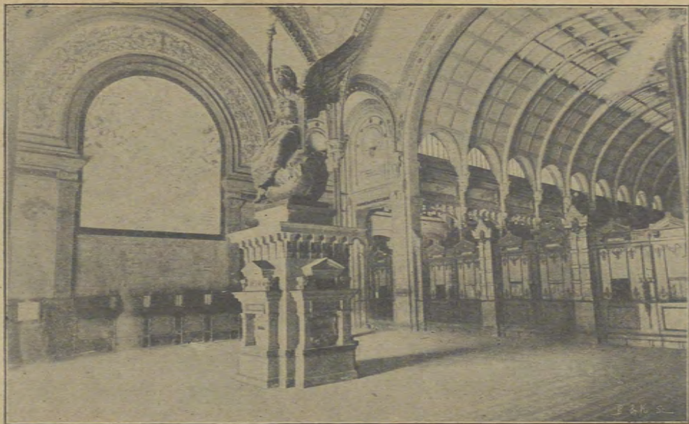
HALL DE L'HÔTEL DES POSTES.
