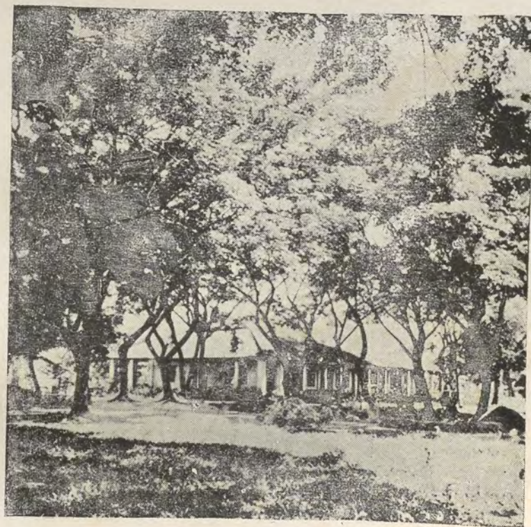
THI-NGHE : Un des bâtiments
