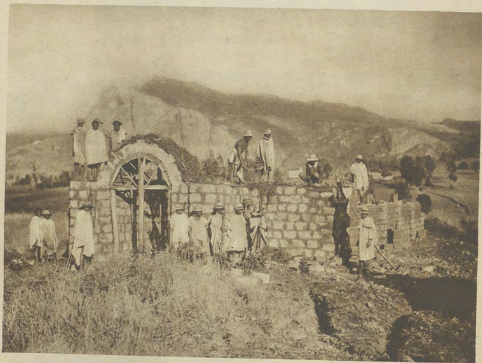
152. LE TRAVAIL AVANCE SOUS LA DIRECTION DU PÈRE.
