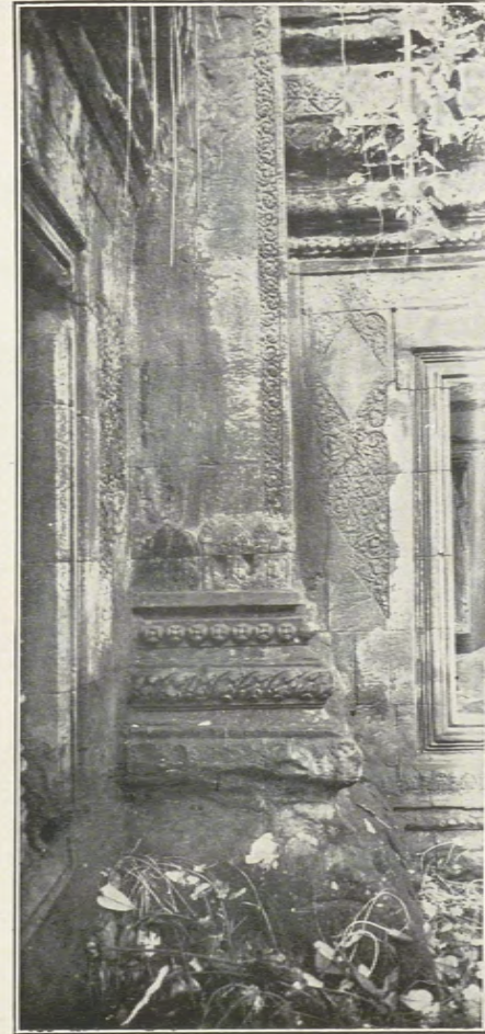
PLANCHE XXIV. — Exemples de décors sculptés arrêtés en cours d'exécution : A, B, (A. V.); C, (Bantéai Samré).
