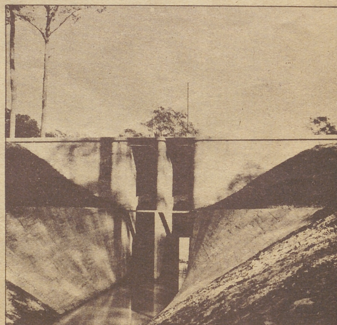
Les travaux hydrauliques du Barai : ouvrage de prix
