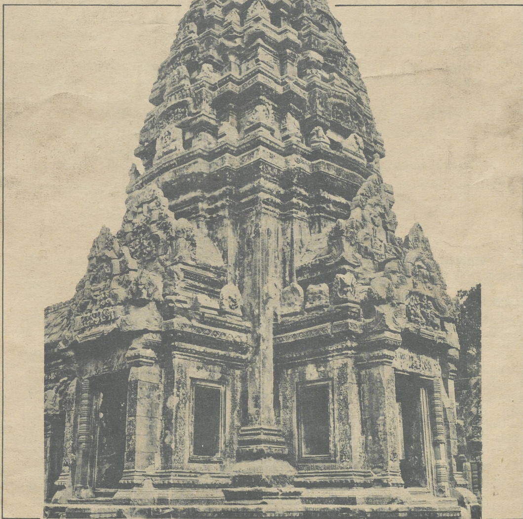
BANTEAY SAMRÊ. — Tour centrale reconstruite
