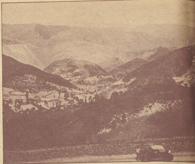
La route domine de plus de 1000 mètres la vallée de la Salouen.
