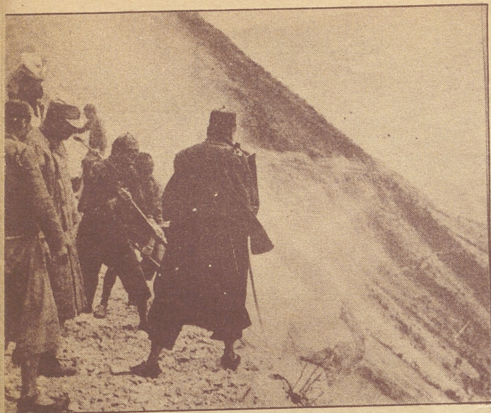
Après un glissement de terrain, on dégage la route.
