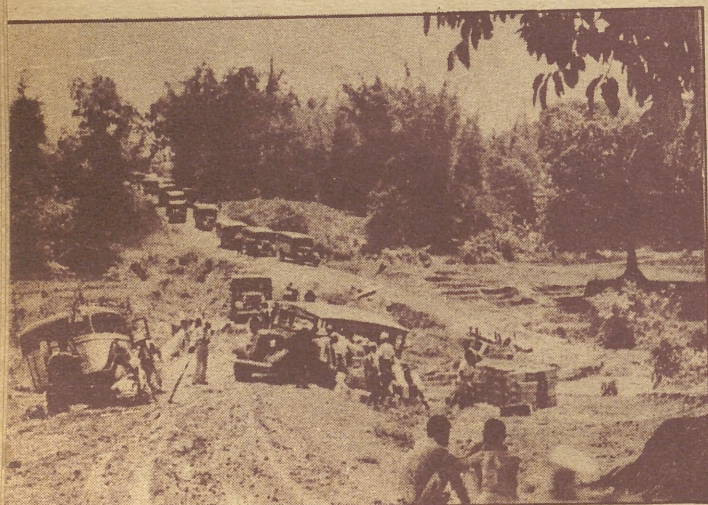
Les ennuis d'une route non empierrée.
