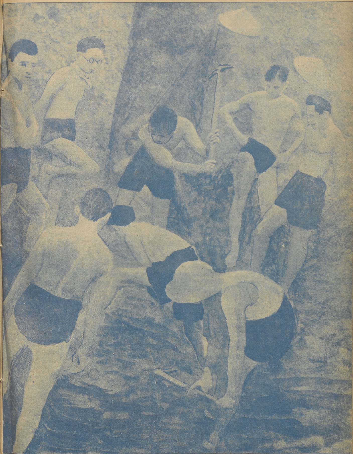
Barrage d'un torrent pour la construction d'une piscine
