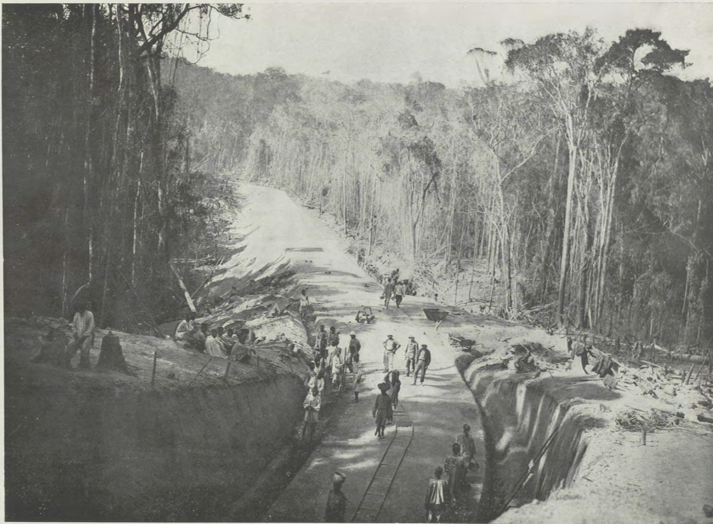
Route de l'Est, chantier d'Ampasimbola en 1898.
