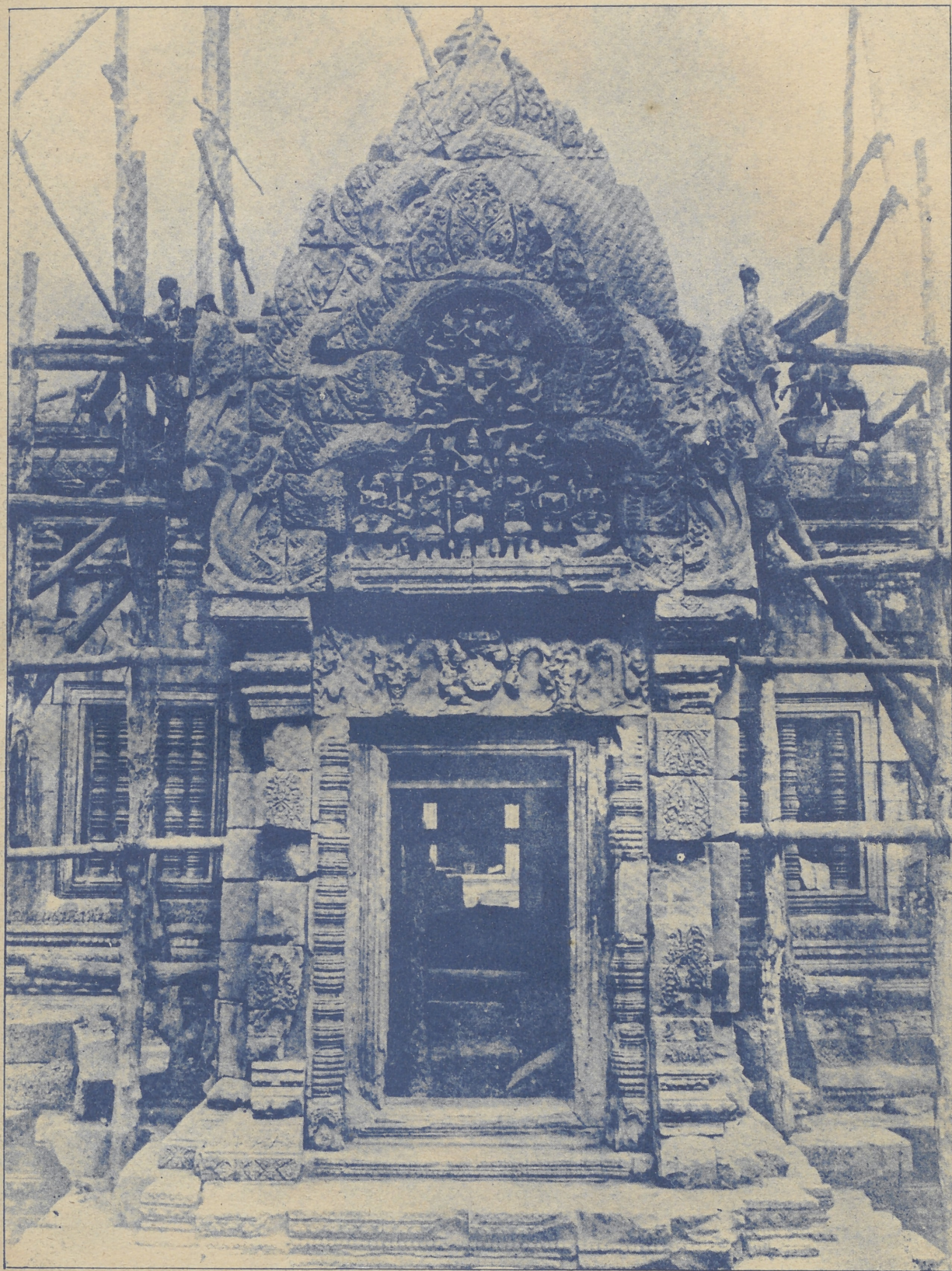
BANTAY SAMRÉ : Pavillon d'entrée Ouest après anastylose
